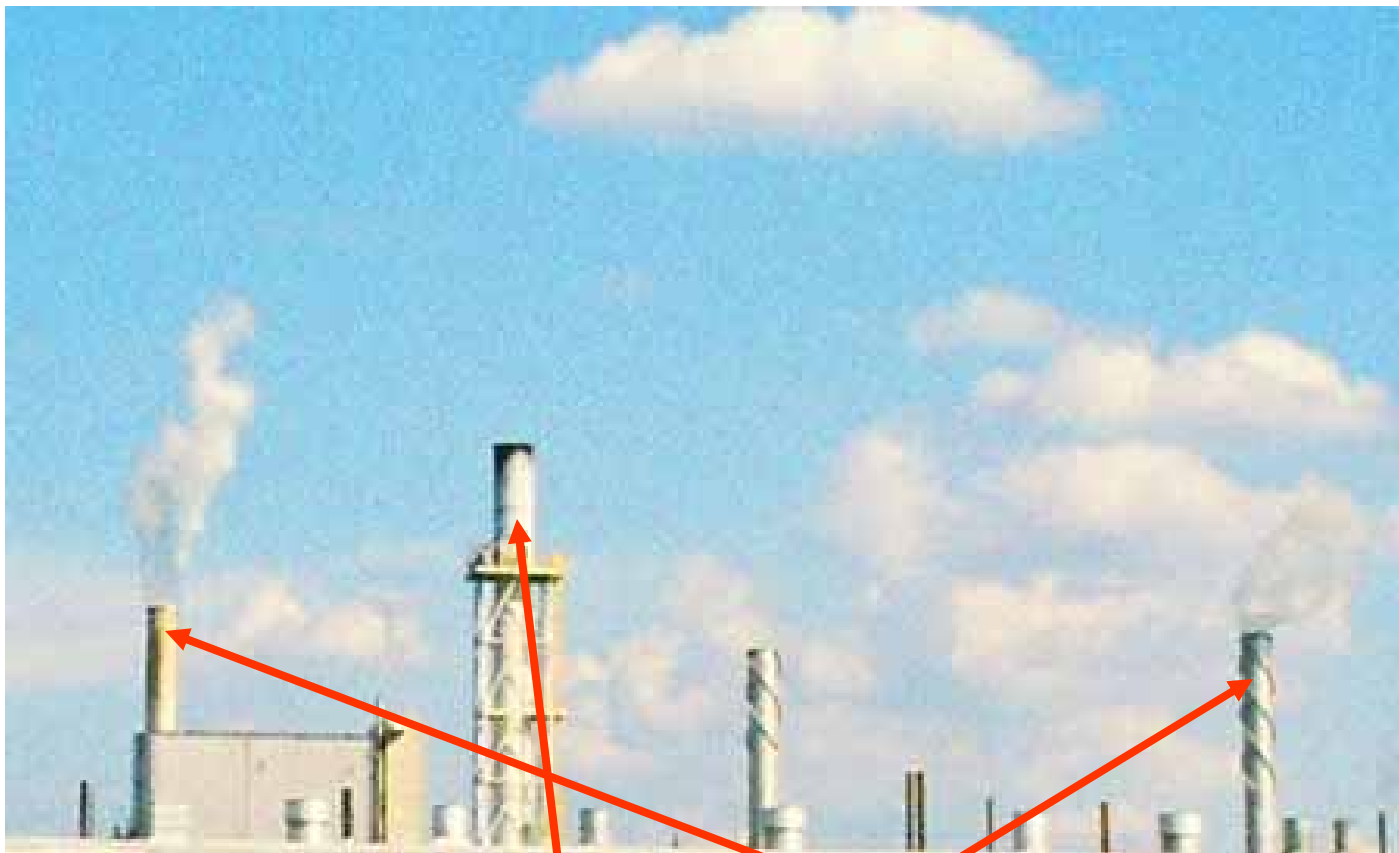
Membrane WESP Stack
